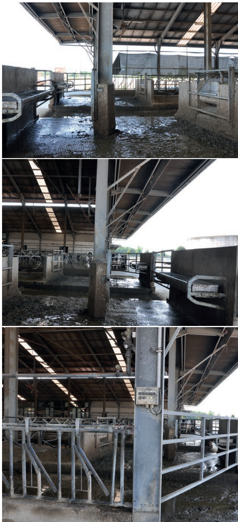
L'allungamento della corsia, che è ben visibile in queste immagini, ha permesso di allargare lo spazio per il movimento delle bovine e di inserire un nuovo ampio abbeveratoio.
